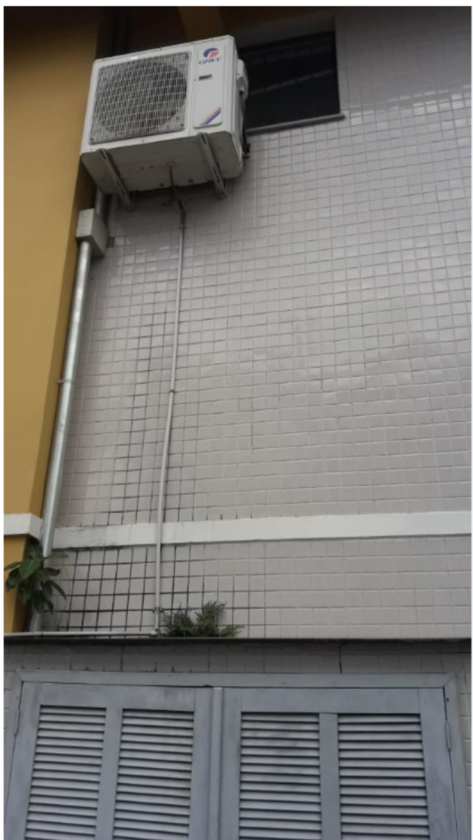
Foto 01: Condensadora com vazamento de água por problemas na tubulação (canos).
