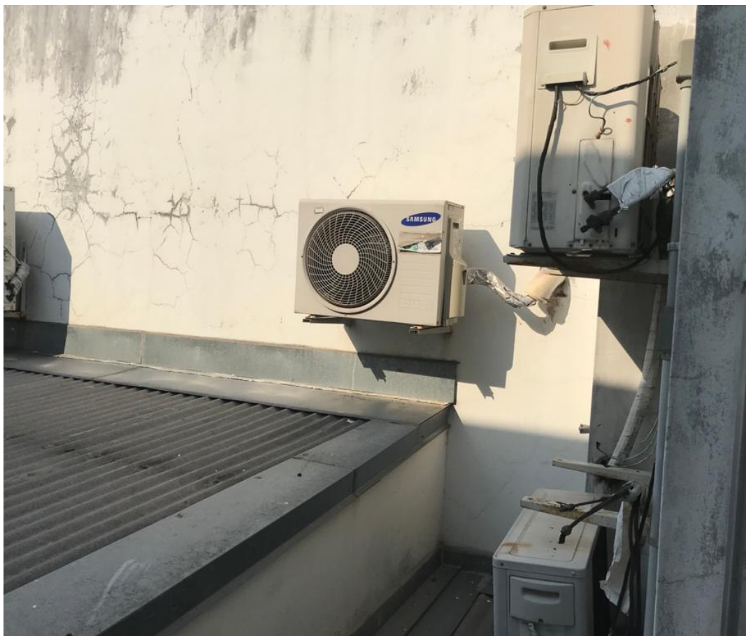
Foto 05: Condensadora do equipamento de 12.000 BTU.
