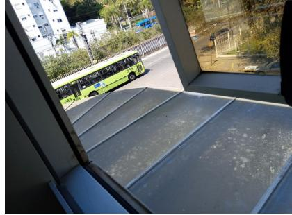
A foto é tirada de cima, mostrando uma marquise com estrutura metálica e telhas de PVC.                        |
