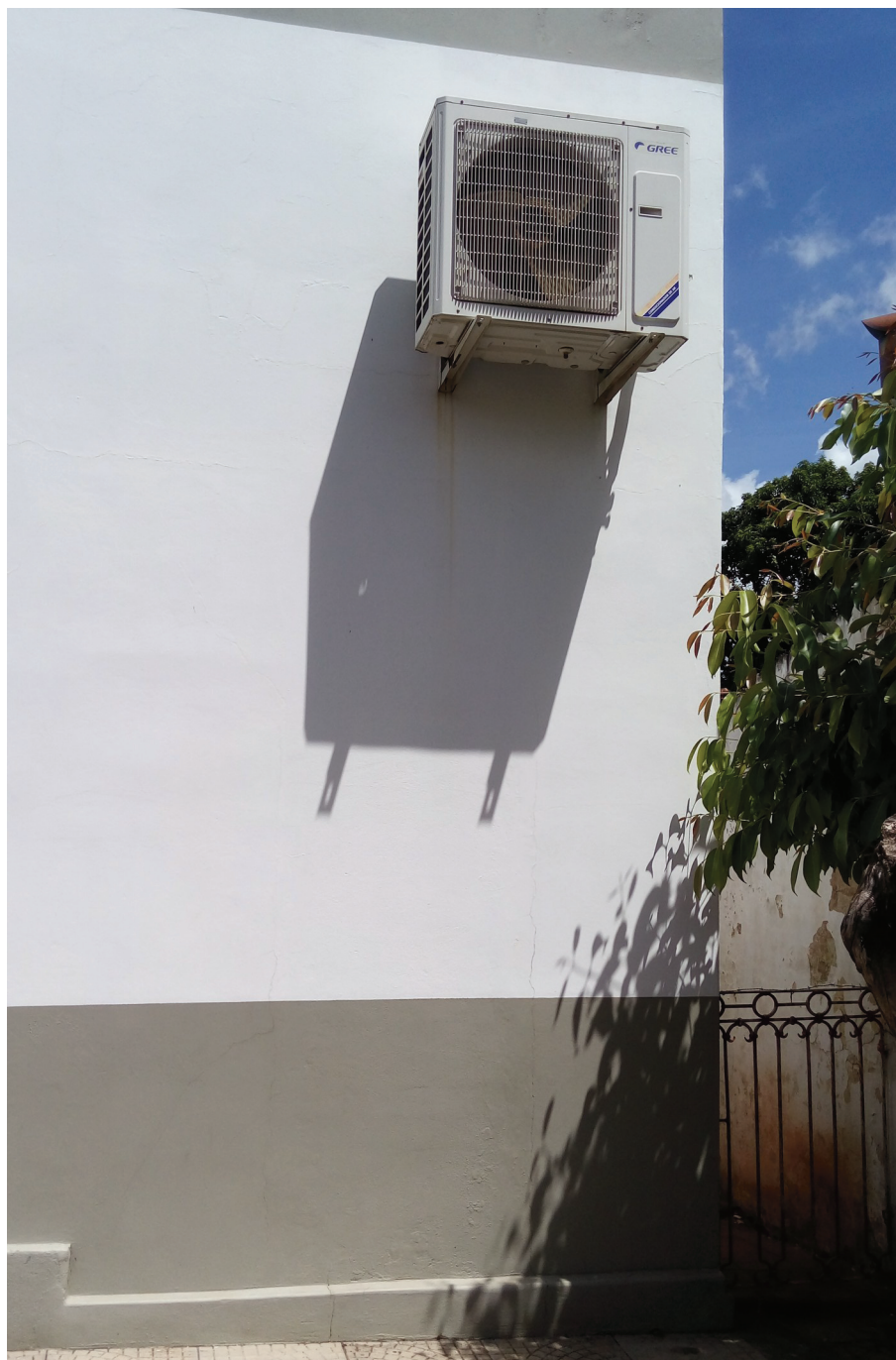
Foto 4 – Situação de instalação da unidade condensadora, item 3.1.2
