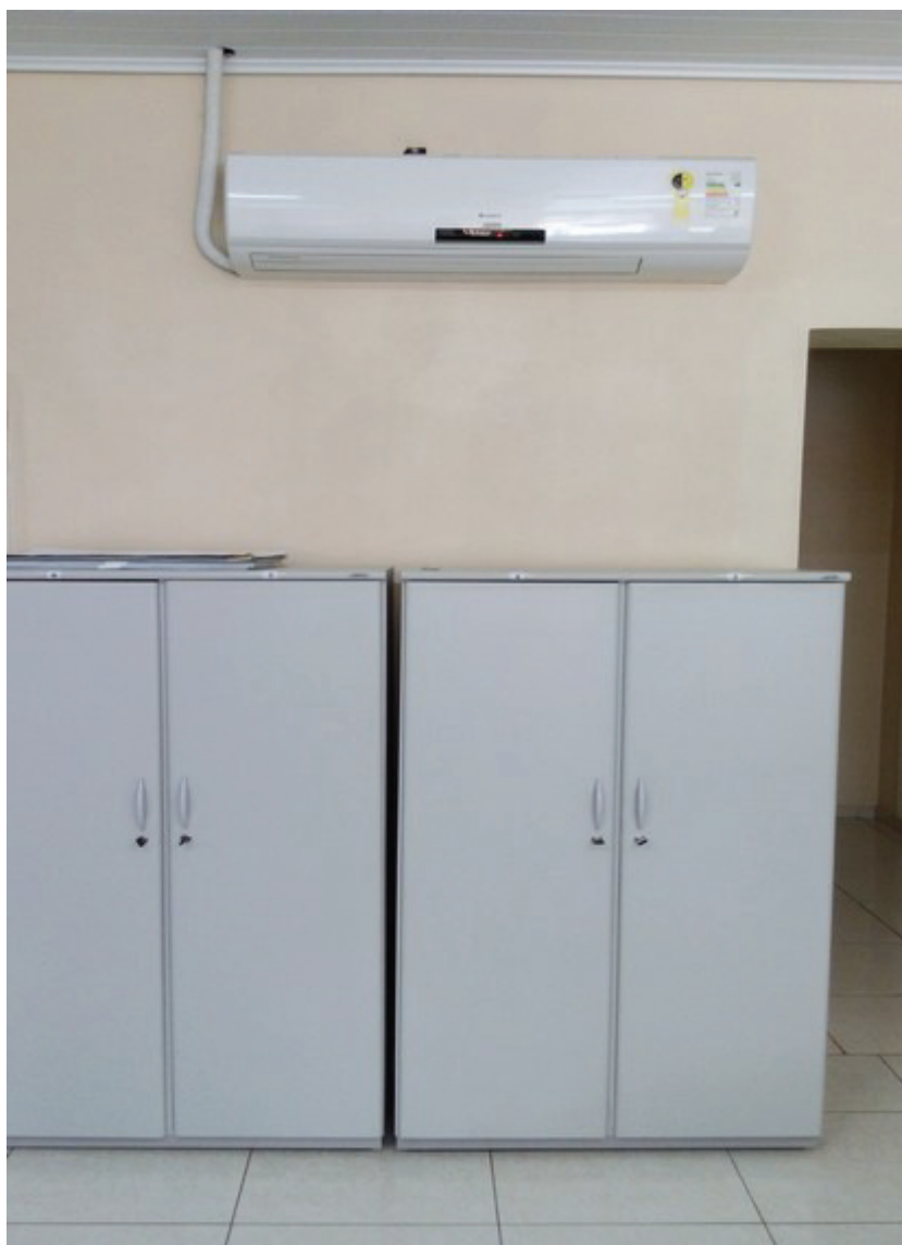
Foto 1 – Situação de instalação da unidade evaporadora (interna), item 3.1.1
