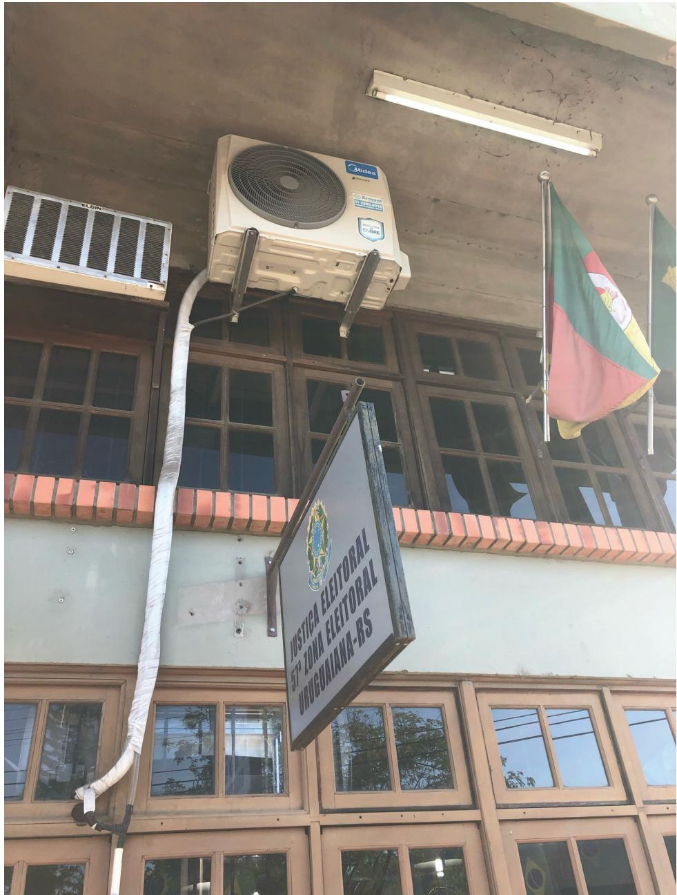
Foto 2 – Situação de instalação da unidade condensadora, item 3.1.1
