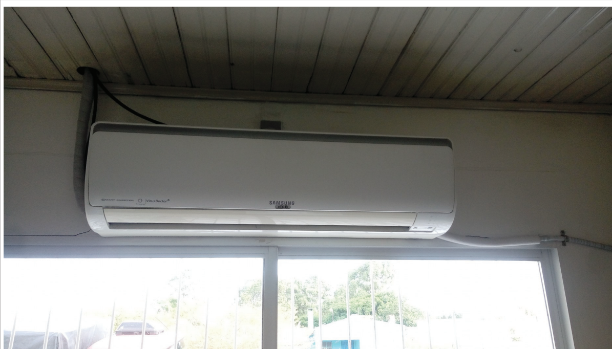
Foto 1 – Situação de instalação das unidades evaporadora, item 3.1.1
