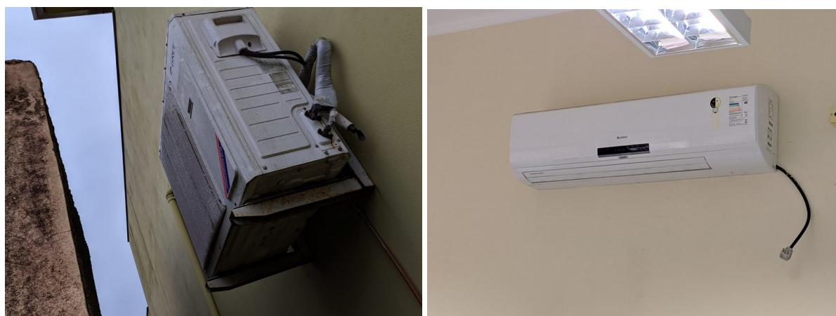
Foto 2 – Situação de instalação das unidades condensadora e evaporadora, item 3.1.1
