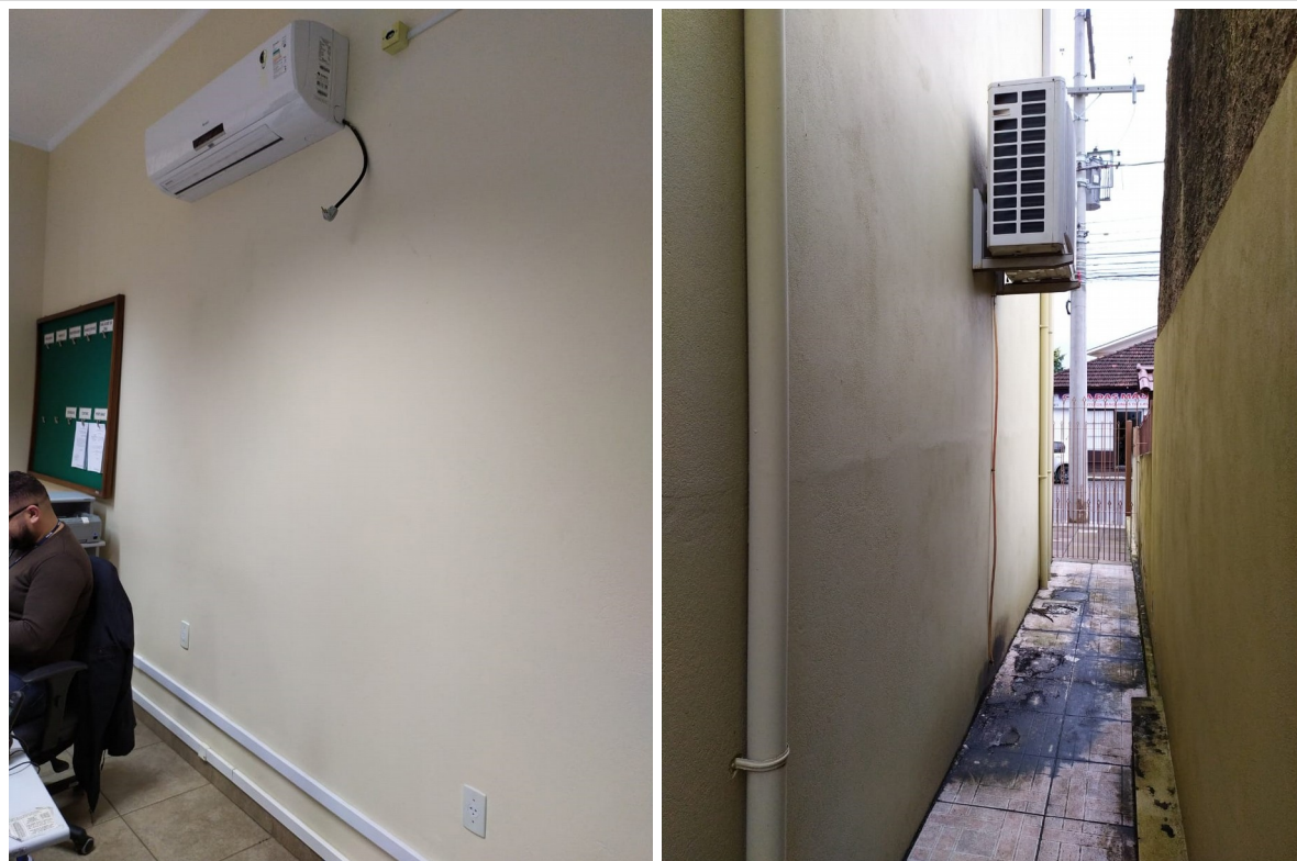
Foto 1 – Situação de instalação das unidades condensadora e evaporadora, item 3.1.1
